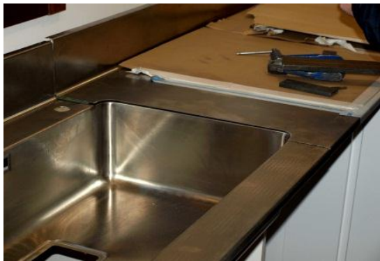
Encajar y sujetar las dos encimeras
