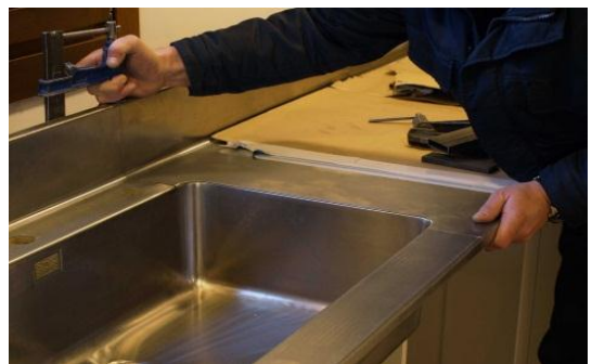
Encajar y sujetar las dos encimeras
