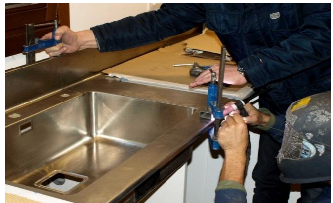
Primeros puntos de soldadura
