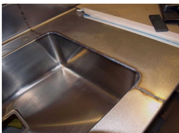
Soldadura vista antes de pulir.
