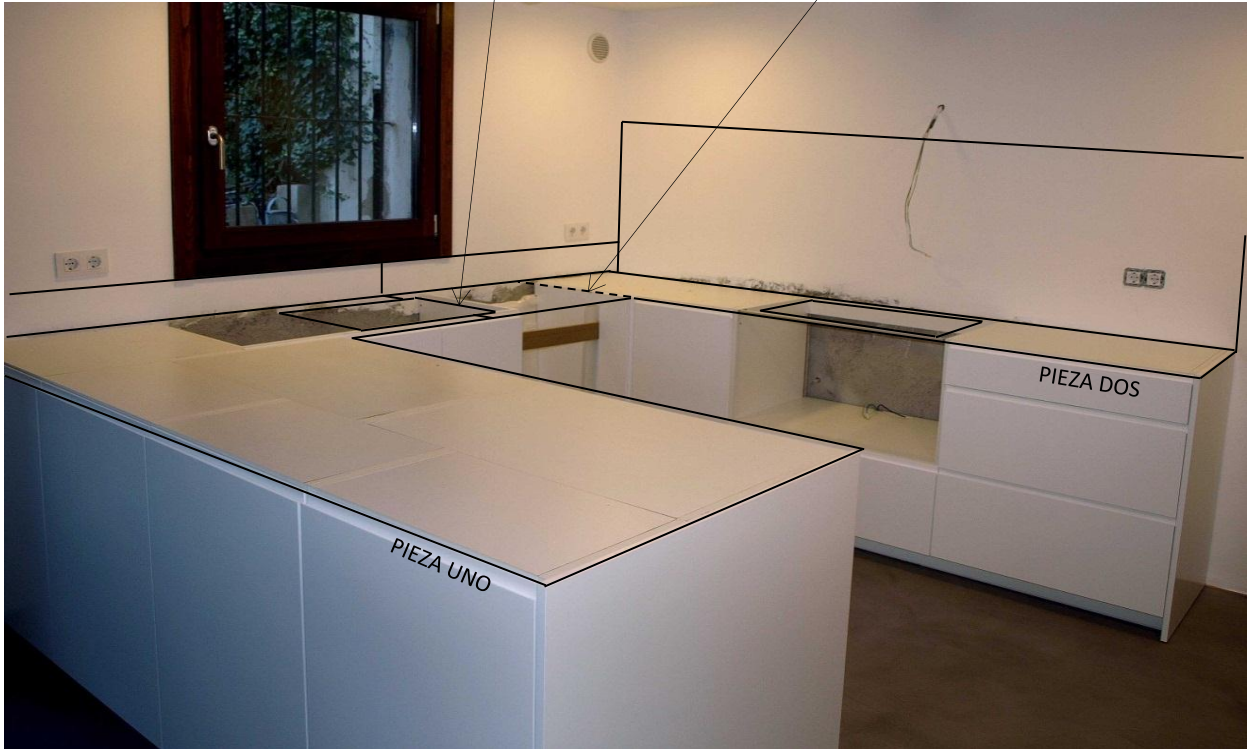
Encajar y sujetar las dos encimeras
