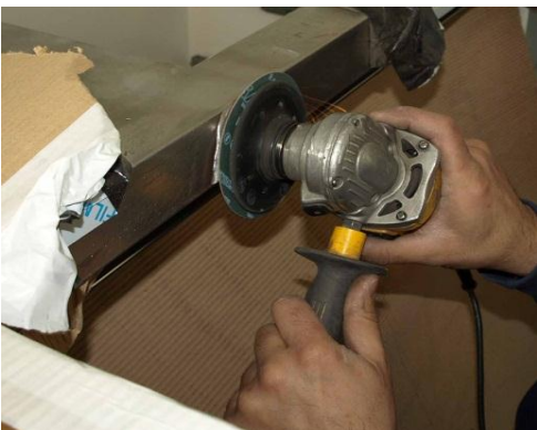
Junta por soldar de las dos encimeras
