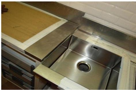
Detalle de la junta de encimeras por donde se realizó la soldadura.
